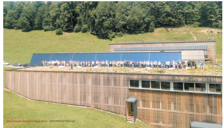
Mit Solarzellen wird die Lüftung betrieben sowie Raumwärme und Warmwasser für die gesamte Produktion erzeugt.
